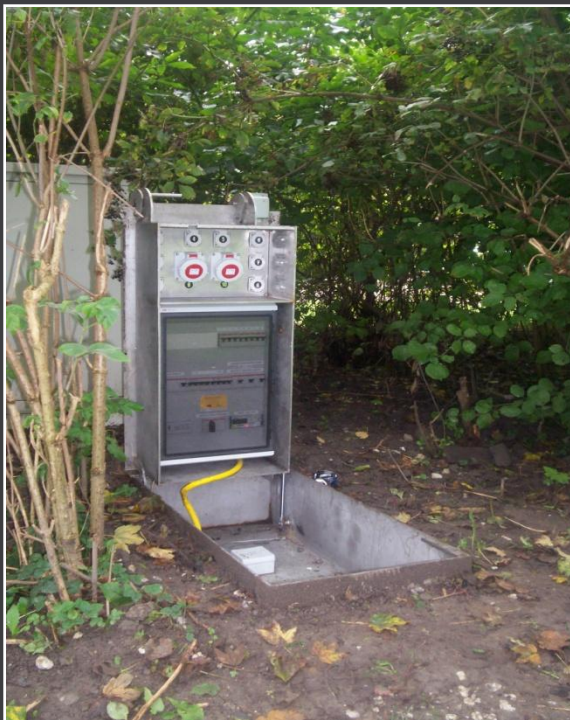
Afsluitbaar deksel Automatisch (hydraulisch) afsluitbaar
