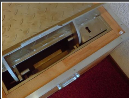
Afsluitbaar deksel Automatisch (hydraulisch) afsluitbaar
